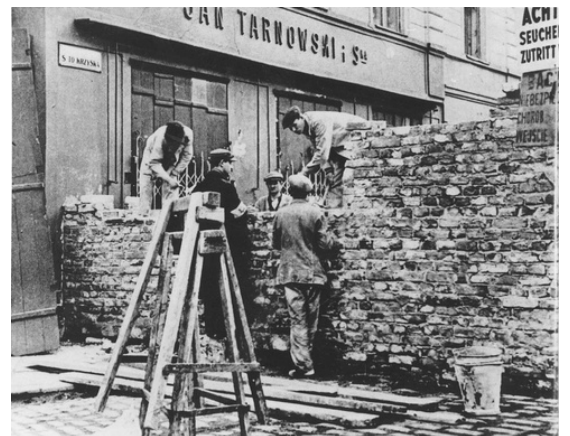
Agosto de 1940: por ordem das forças de ocupação alemãs, começa a construção do muro do Gueto de Varsóvia.
